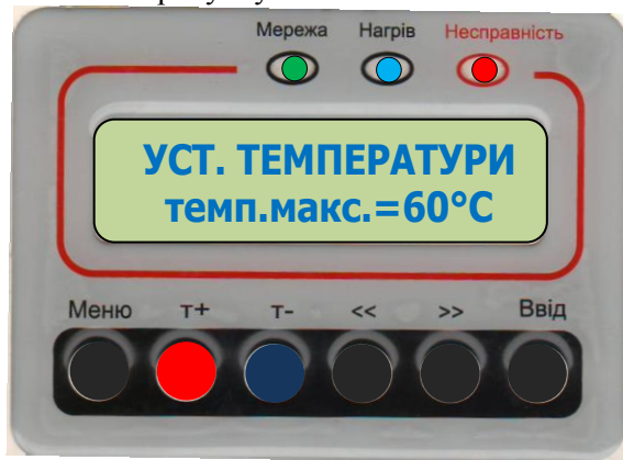
Рис. 10 Вид панелі управління при установці температури нагріву теплоносія (води) другим способом
